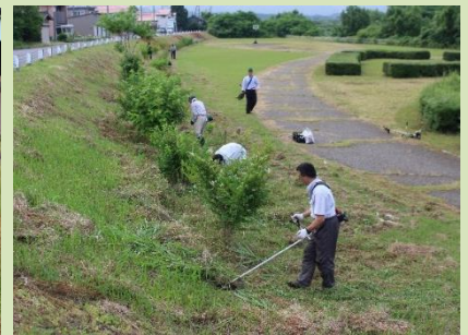
作業中 上流部
